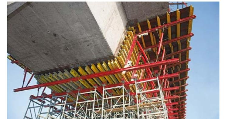
*Детали соединяются в единую вспомогательную конструкцию любого размера и геометрической формы*
