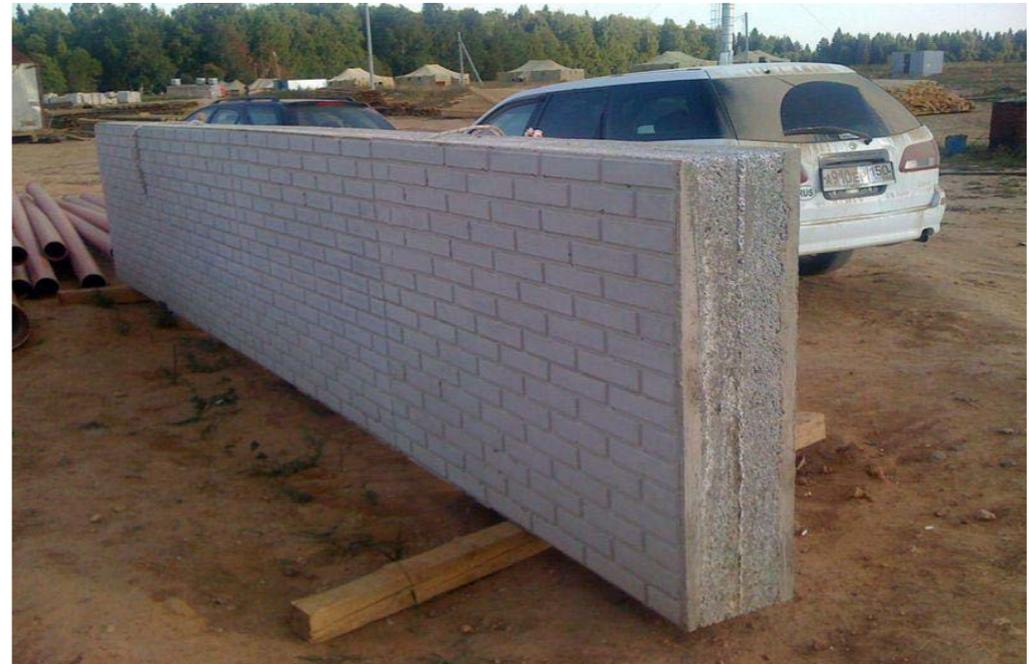
Сэндвичевая плита ограждения с внешним слоем из плотного БКМВ-бетона.
