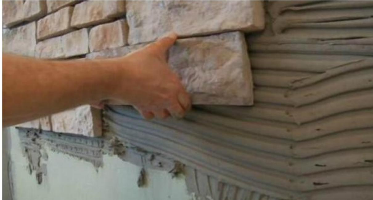
Двухкомпонентный высокопрочный клей
